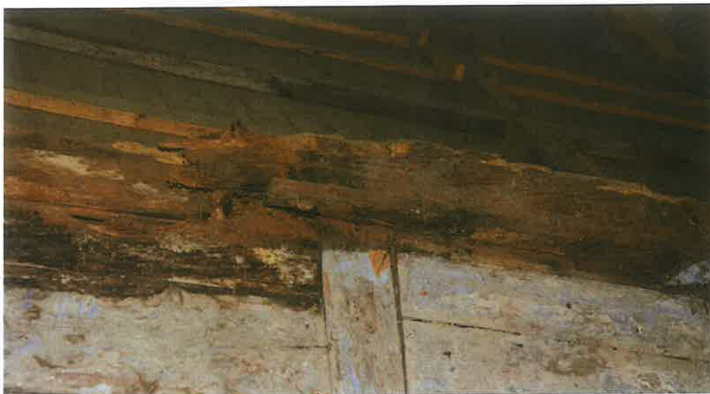
Fotografia nr 5. Degradacja oczepu ścian wewnętrznych.
