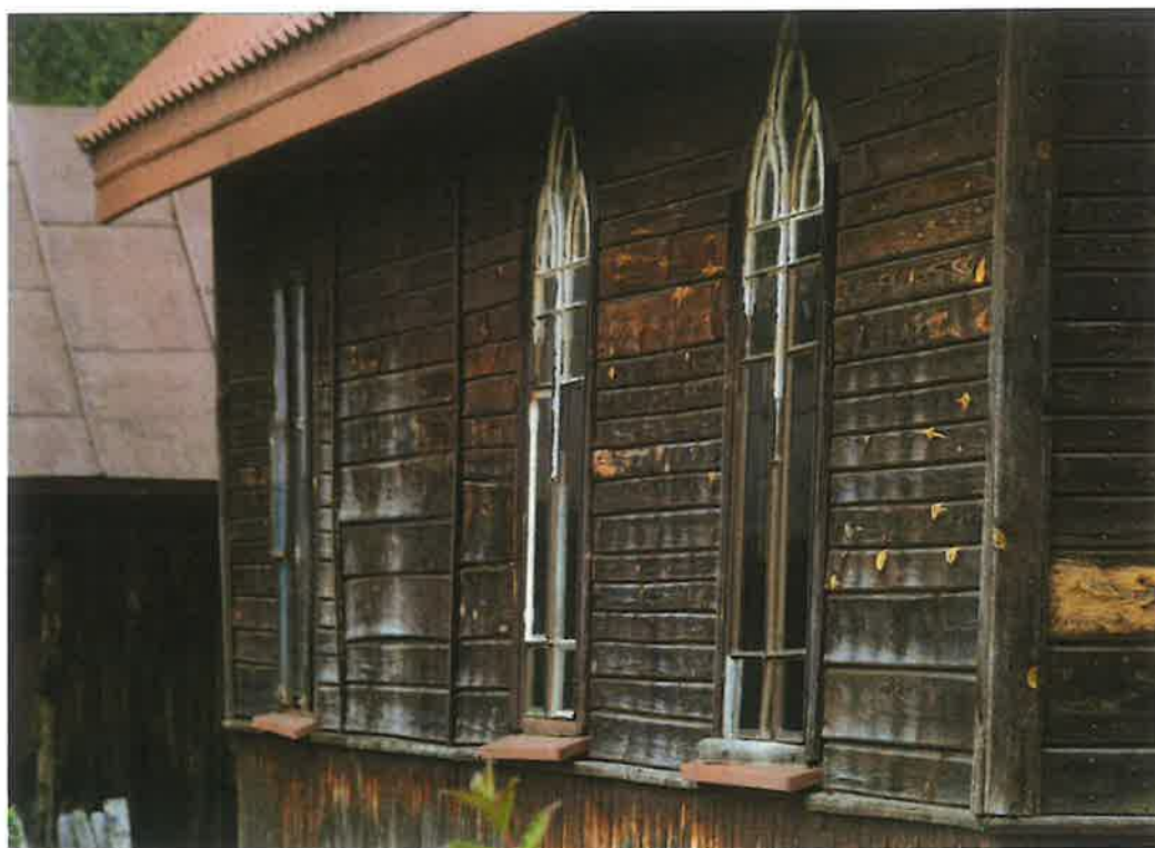
Fotografia nr 13. Ściana południowa z widocznymi wypaczeniami desek elewacyjnych.
