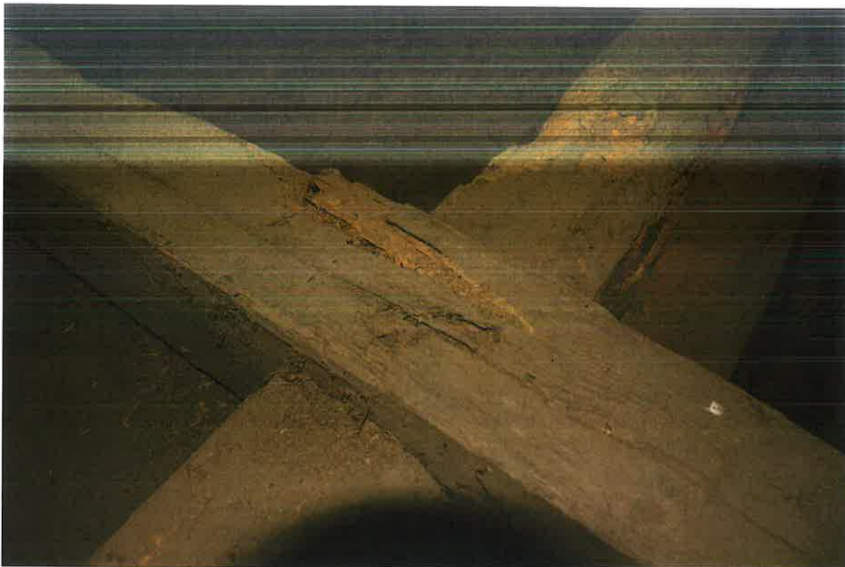
Fotografia nr 3. Połączenie belki stropowej z belką oczepowej.
