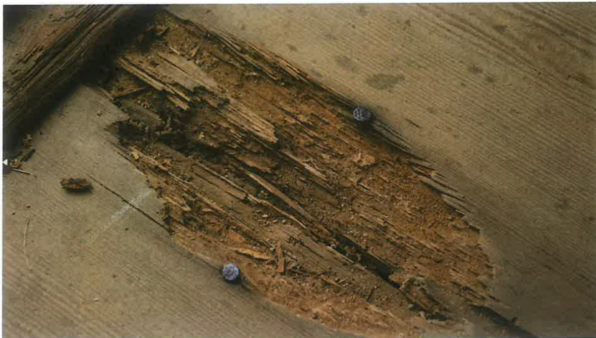
Fotografia nr 18. Skutki żerowania szkodników drewna w deskach podłogowych.
