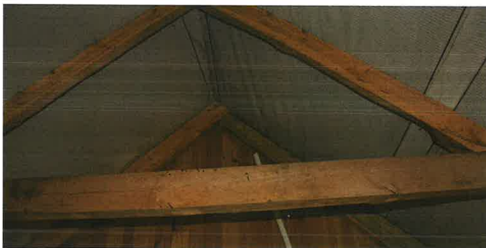
Fotografia nr 15. Konstrukcja krokwiowo-jętkowa więźby dachowej.
