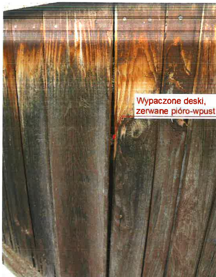
Fotografia nr 6. Elewacja południowa – wypaczenie desek
