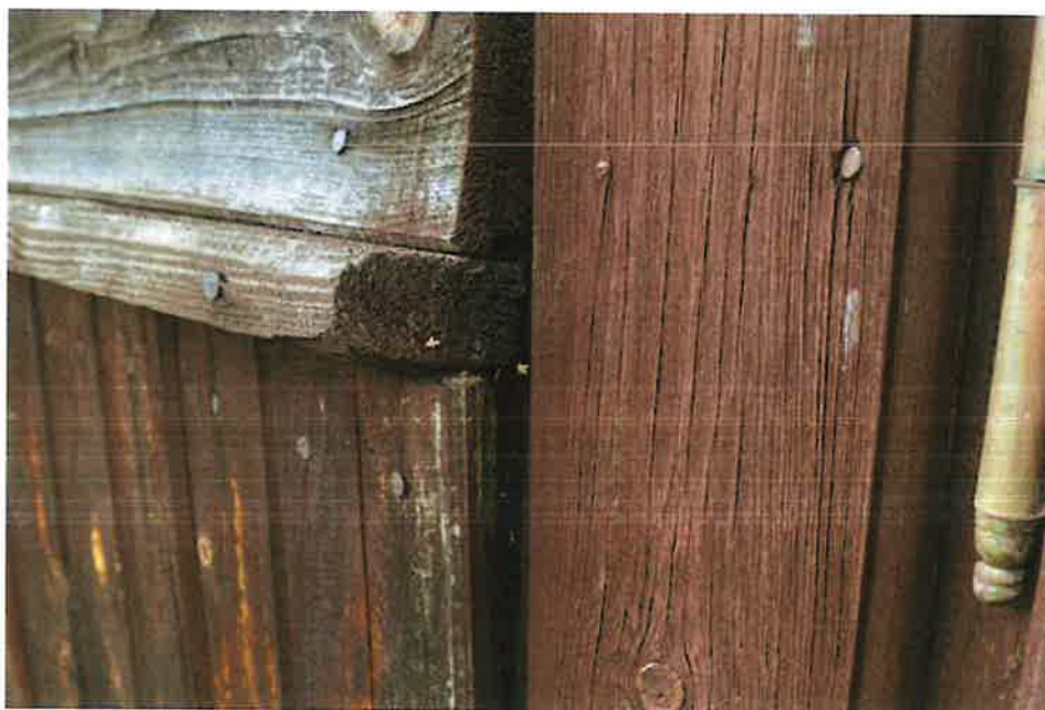
Fotografia nr 7. Okapnik ze spadkiem w stronę konstrukcji nośnej.
