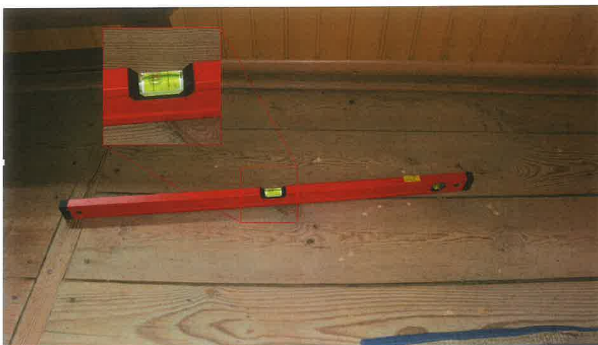
Fotografia nr 19. Odchylenia od poziomu podłogi budynku.
