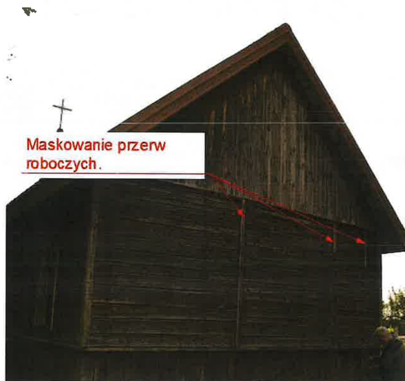
Fotografia nr 11. Niesymetryczny, mało estetyczny podział elewacji. Łączenia w miejscach przypadkowych.
