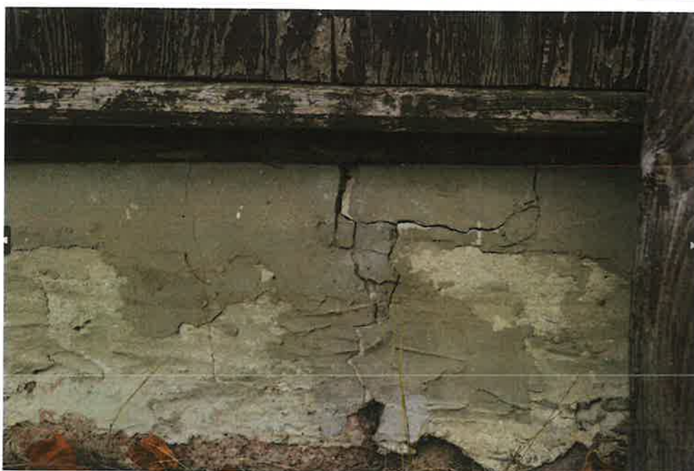
Fotografia nr 1. Fundament kamienny z podmurówką ceglana otynkowaną tynkiem cementowym. Widoczne zarysowanie fundamentu .
