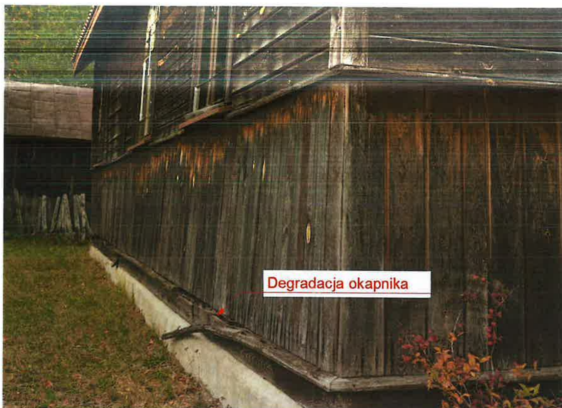
Fotografia nr 10. Elewacja południowa – widok ogólny z widoczną zniszczoną listwą okapową
