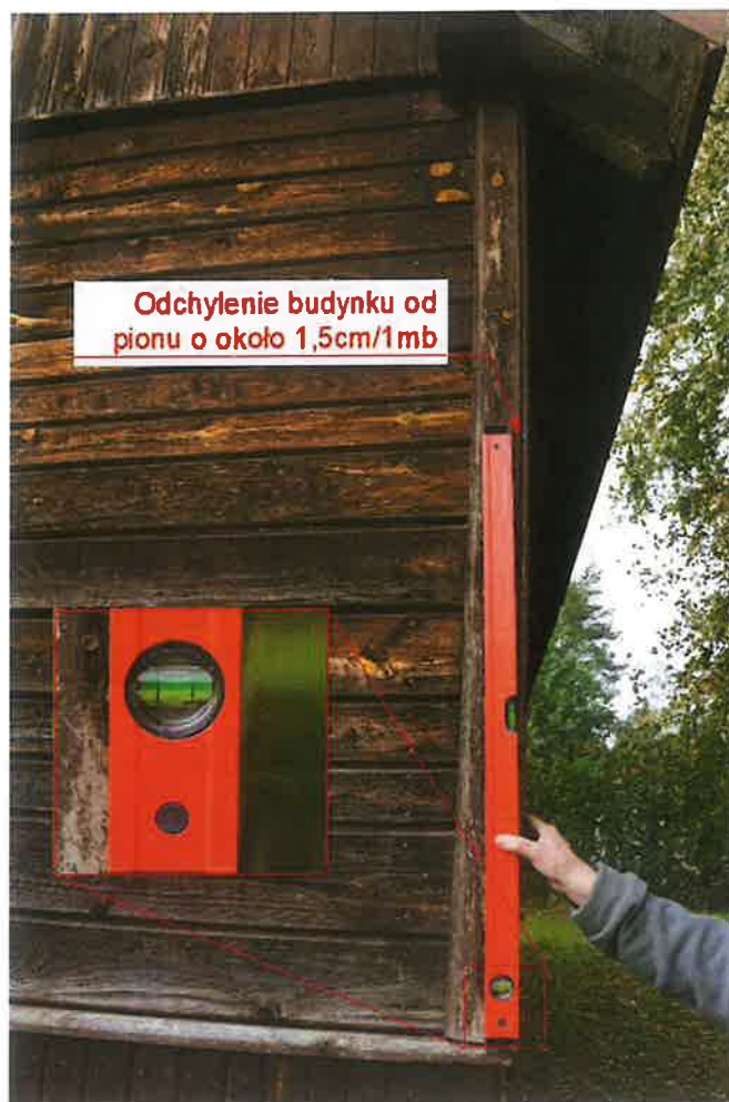
Fotografia nr 8. Widok ściany szczytowej. Odchylenie budynku od pionu.
