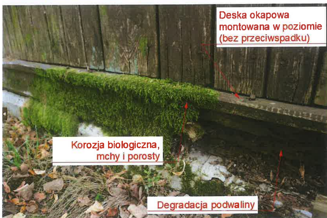
Fotografia nr 2. Elewacja północna . Korozja biologiczna desek, degradacja podwaliny i deski maskującej. Deska okapowa zamontowana bez przeciw spadku.
